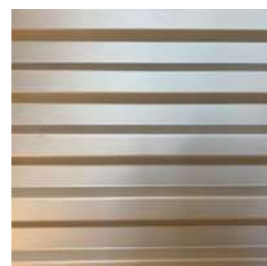
Facade: Ny trapezplade i galvaniseret stål, Profil 20-105
