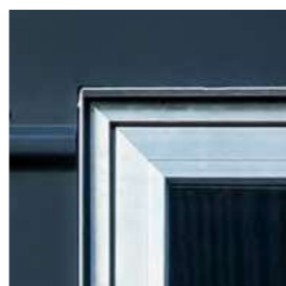
Vinduer, døre og vindues inddækning: Udv. lysninger i bukket galvaniseret stål, vindue i rå alu
