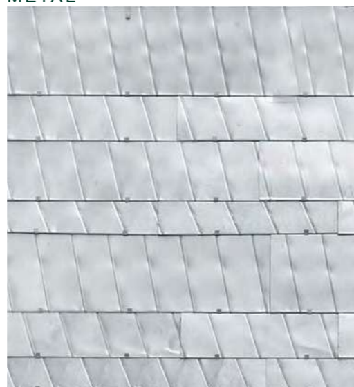
Genanvendt spiro rør
