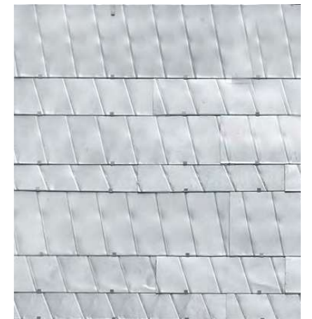
Genanvendt spiro rør
